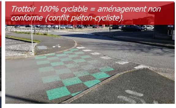
Fin de piste cyclable accidentogène, en intersection avec voirie très circulante. Marquage de la traversée effacé. Peu de visibilité.
