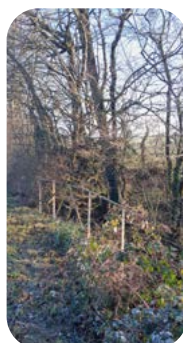
Pont de l'Aunisière (12/2024)
