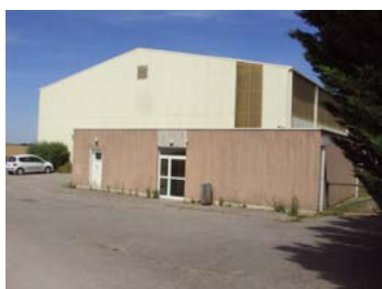
Photos avant les travaux
