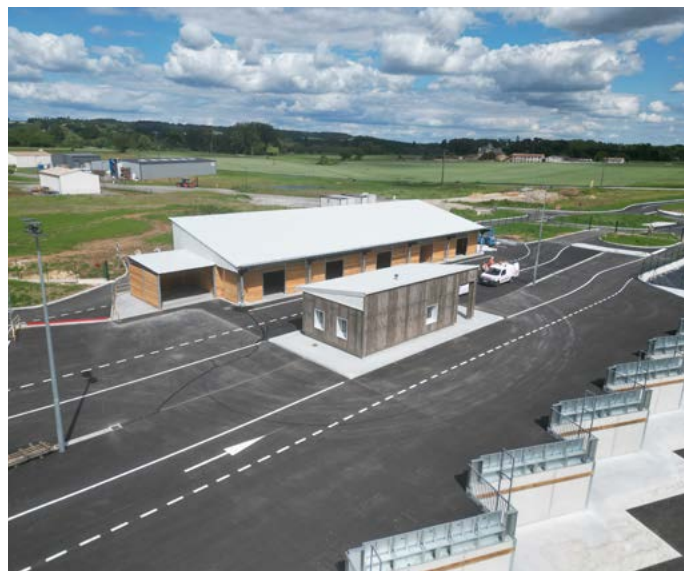
Déchetterie à Saint-Martin-la-Pallu
